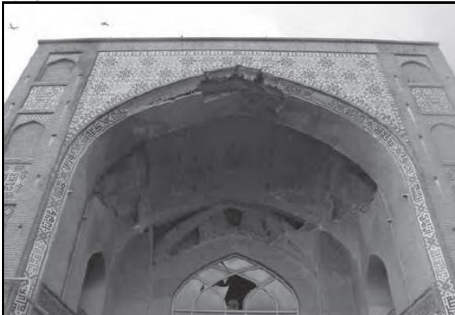
نمونه‌ای از خسارات وارد شده به تارک‌کاری‌ها و نما در زلزله ۱۳۸۵ لرستان حفاظت شخصی و گروهی در شرایط جنگی - حلمد حق
