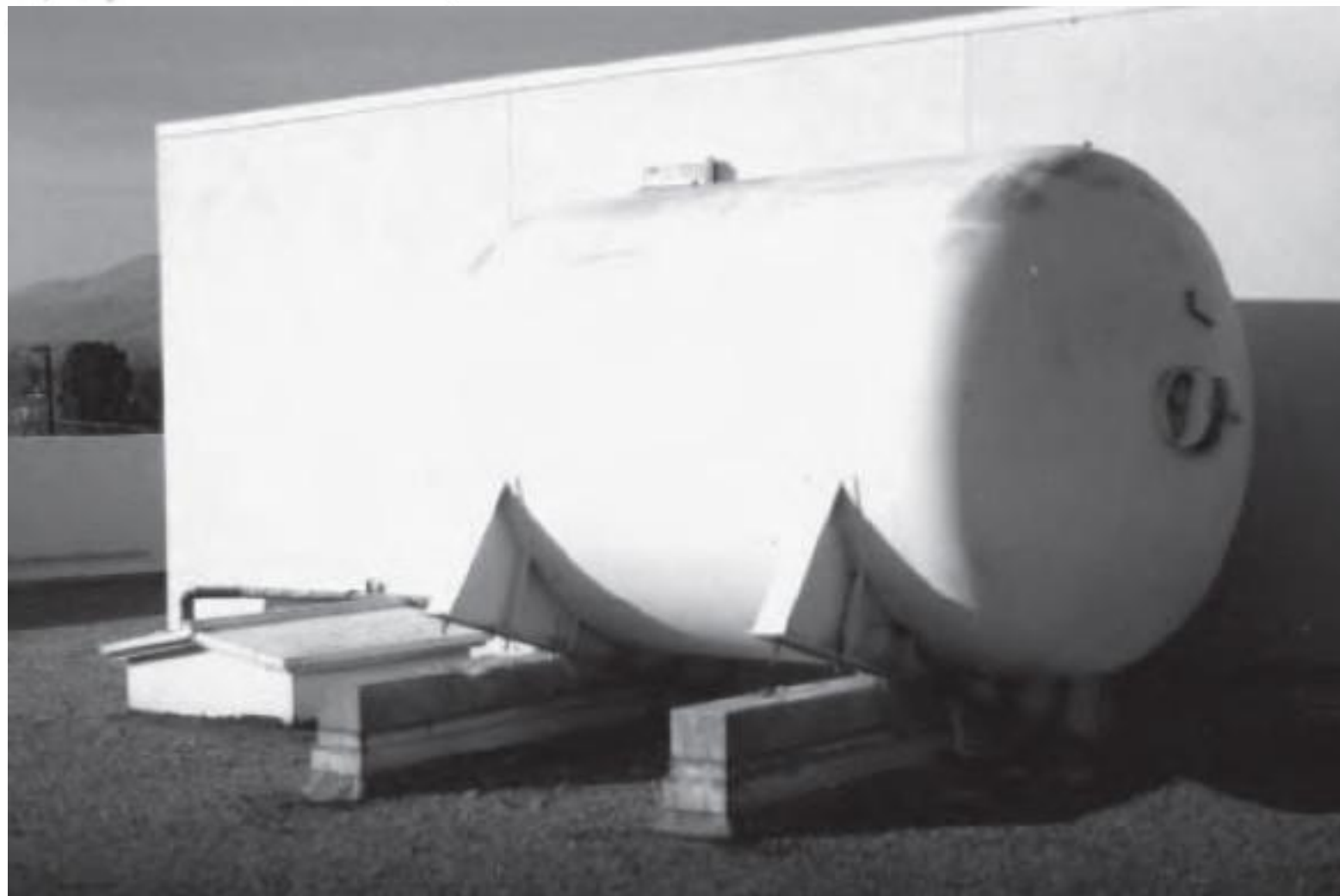
نمونه‌ای از خسارات وارد شده به مخازن گاز در اثر زلزله ۱۹۹۴ نورتریج
