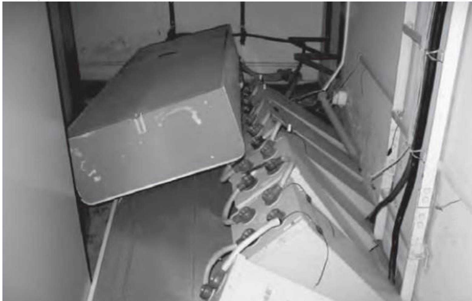
واژگونی باتری های مربوط به ایستگاه تلفن همراه دوجیانگیان در اثر زلزله ۲۰۰۸ چین حفاظت شخصی و گروهی در شرایط جنگی - حامد حقی
