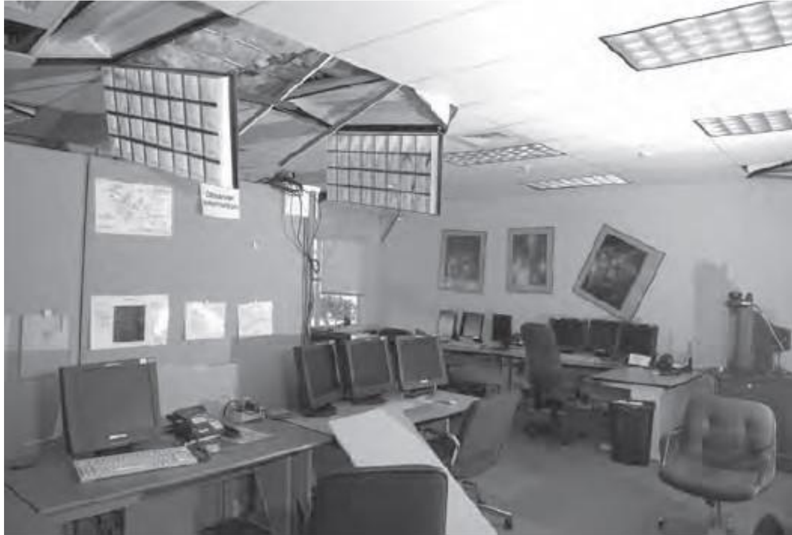
نمونه‌ای از خسارات وارد شده به چراغ‌های آویز در زلزله حفاظت شخصی و گروهی در شرایط جنگی - حامد حقانی
